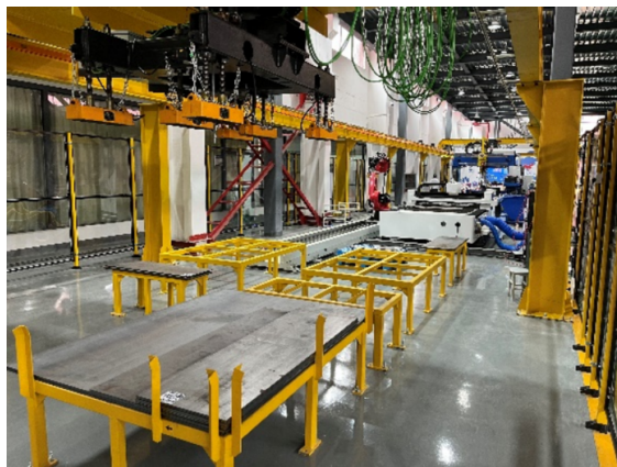
图4 智能堆场和智能行车现场
